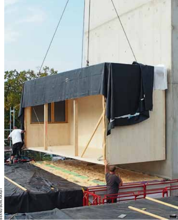
▲ Montage eines vorgefertigten Raummoduls an den Erschließungskern
