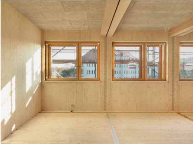
▲ Die Schulklassen, die Mensa und die Nebenräume basieren alle auf einem einzigen Grundmodul aus Fichtenholz
