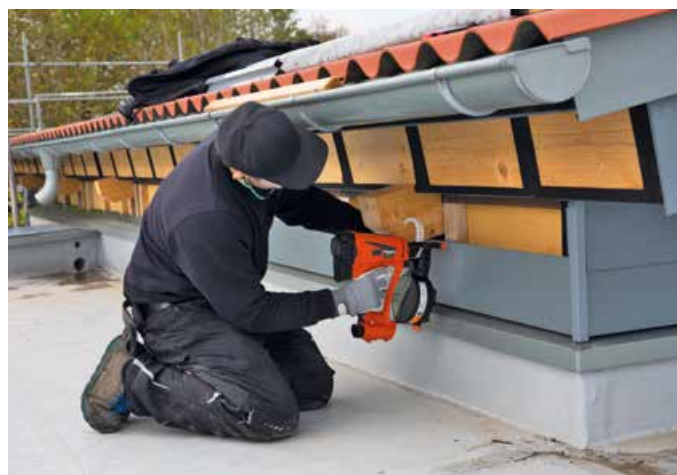
▲ Die Montage der Fassadenbekleidungen erfolgte auf der Holzrahmenkonstruktion der Pultdächer
