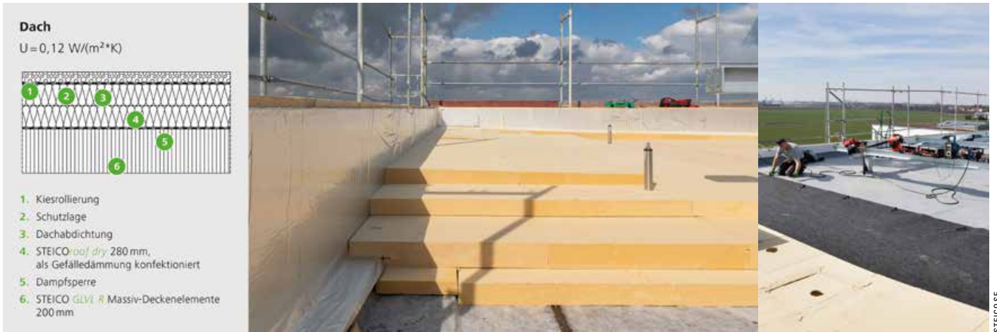
Steico roof dry als Gefälledämmung auf dem Erweiterungsbau der Steico Firmenzentrale – mit renommierten Abdichtungssystemen kombinierbar
