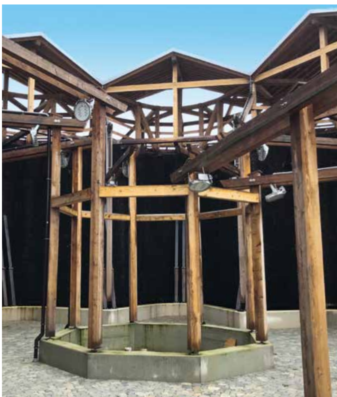
▲ Runde Sache: Das Gradierwerk ist wie eine Pilgermuschel aufgebaut. Die einzelnen Böcke sind jeweils im Winkel zueinander verschwenkt
