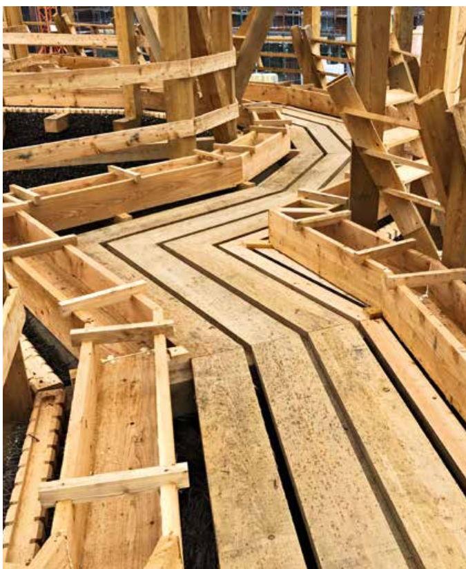
▲ Rinnen, Wegeführung, Konstruktion: Diese Bestandteile des Gradierwerks bestehen aus Lärchenholz
