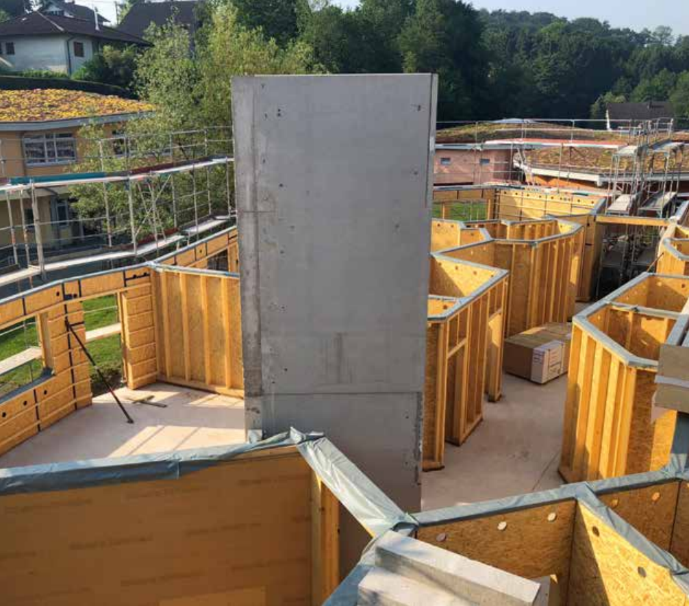
▲ Verlegung der Decke mit fertiger Untersicht
