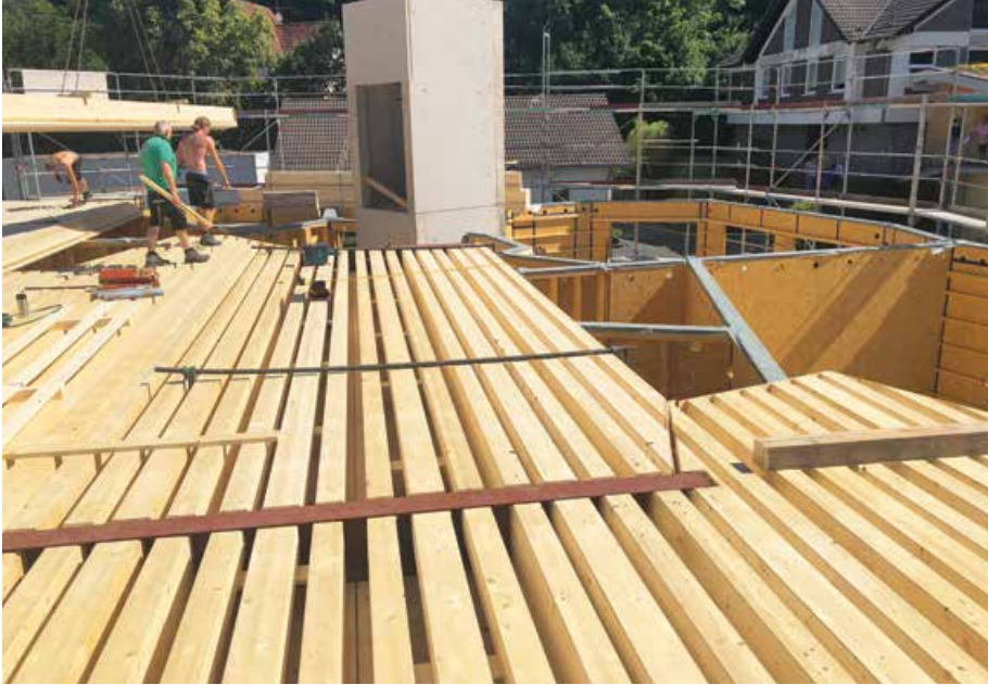
▲ Erdgeschosswände im Holzrahmenbau mit Aufzugschacht
