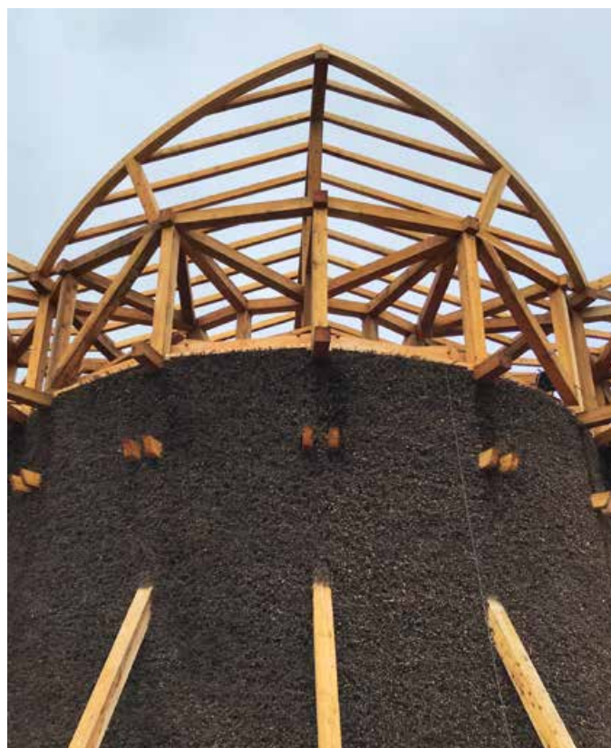
▲ Die Dachkonstruktion überzeugt durch schräge Sparren und gerundete Binder
