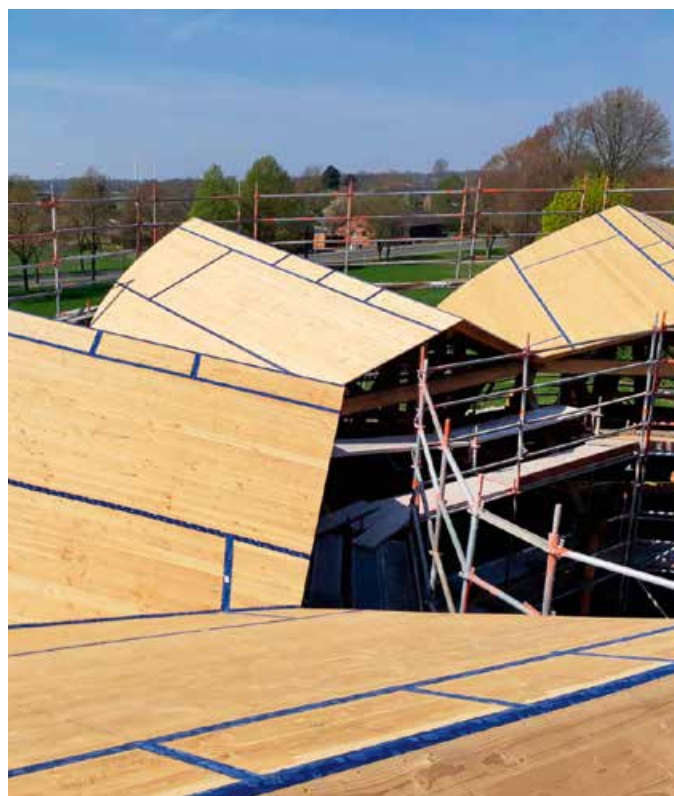
▲ Die Dachkonstruktion besteht aus Lärchenholzsparrn, die auf der Oberseite mit Lärche-Dreischichtplatten beplankt wurden
