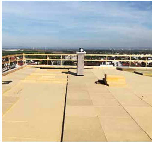
Ökologisches Flachdach im Wohnungsbau: links ein Anbau aus dem Kreis Euskirchen, rechts ein Wohnhaus in der Südpfalz
