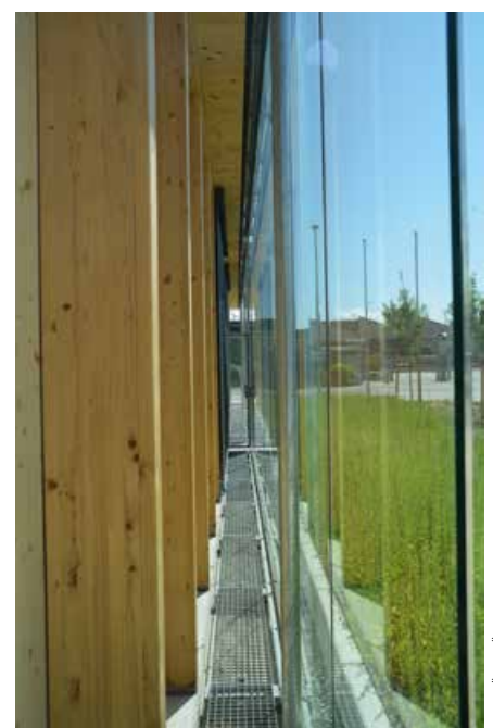
▲ Eine Besonderheit des Gebäudes ist die vorgehängte Glasfassade als konsequenter Holzschutz
