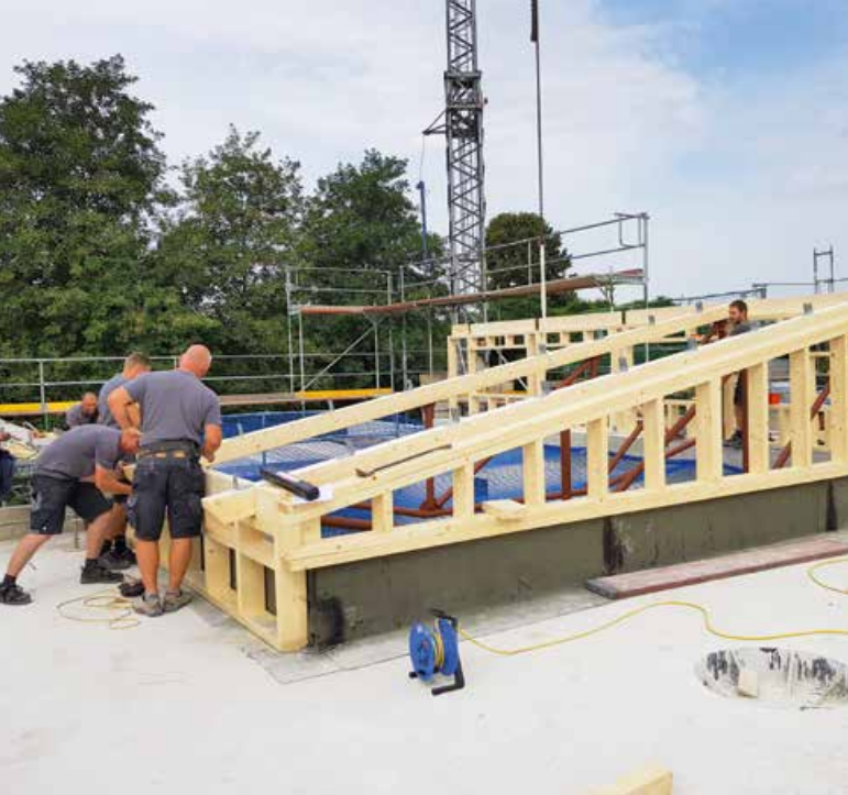
▲ Basis der in Holzrahmenbauweise ausgeführten Pultdach-Konstruktion ist ein Dachstuhl in Stahl-Holz-Fachwerk
