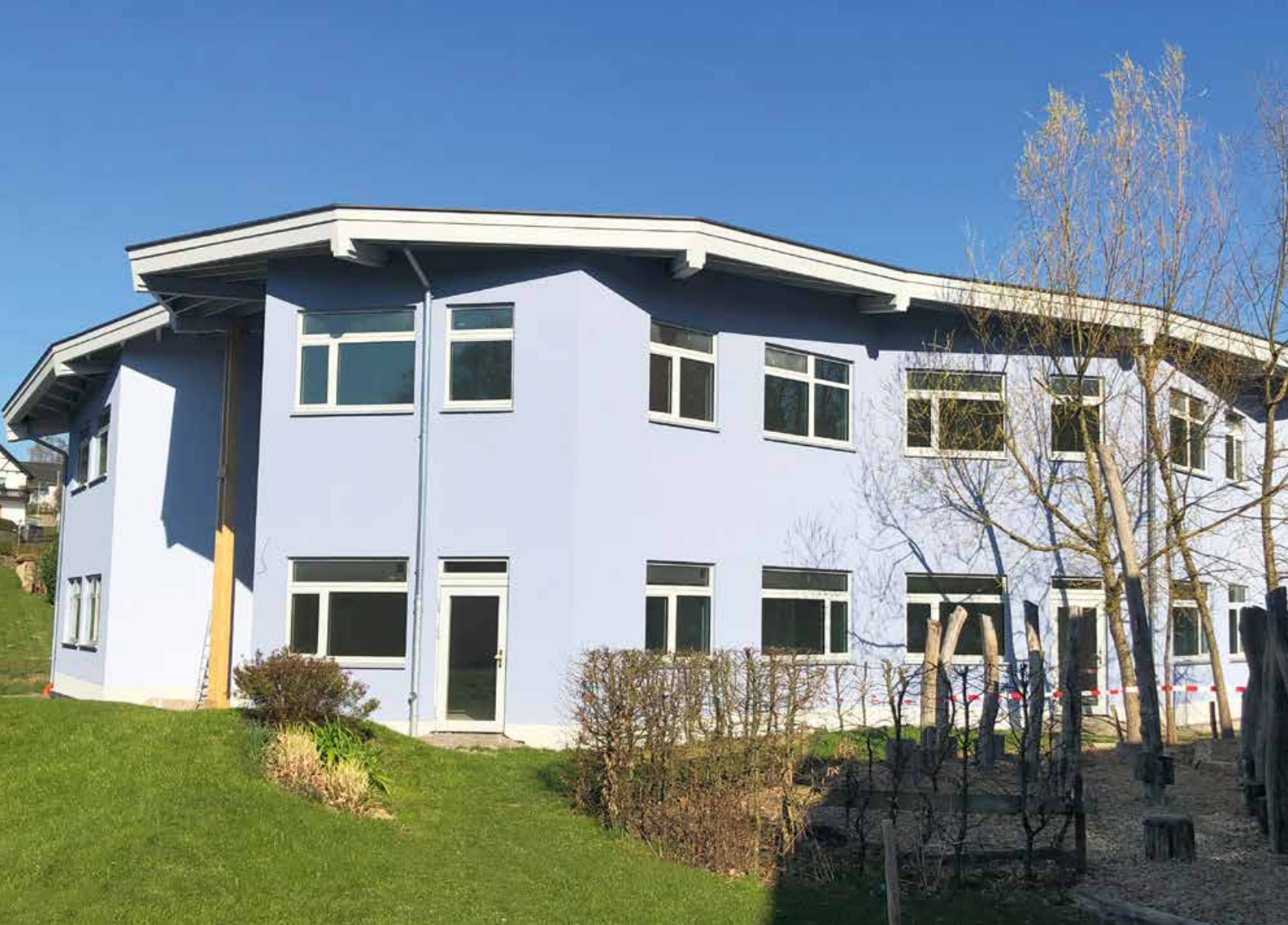
▲ Ansicht Südwest- seite, noch ohne Sonnenschutz
