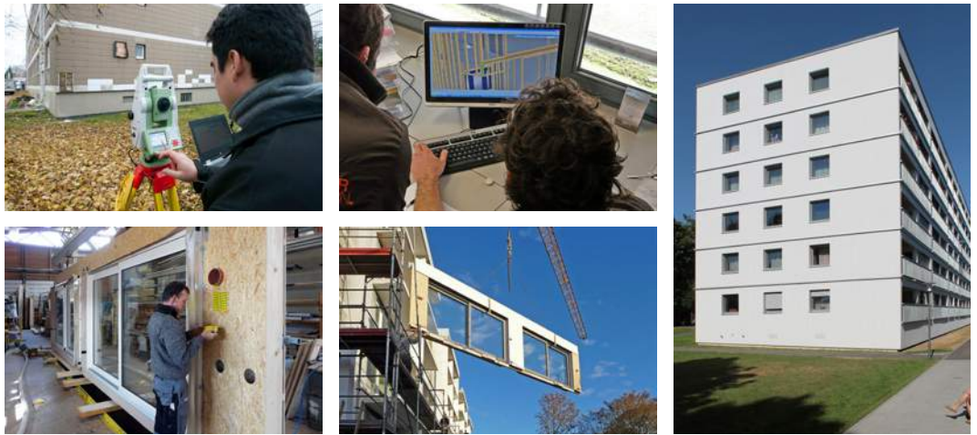
Abb. 6.9 bis 6.13: Bau- und Produktionsab- lauf für TES EnergyFacades (TES = Timber Element System): Vermessung, Pla- nung, Produktion, Montage, Betrieb.
