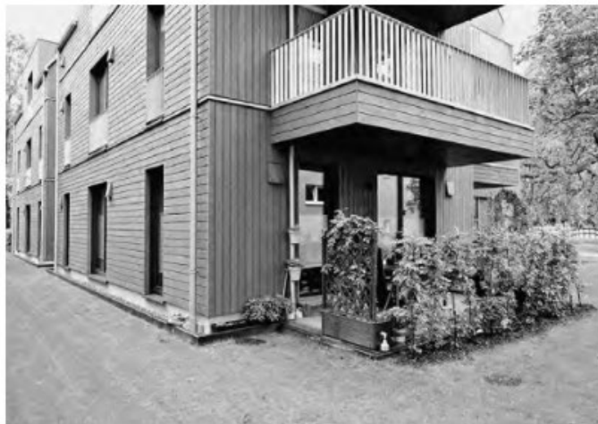
Von außen betrachtet fallen an den Obergeschossen weit auskragende Balkone auf, von denen jeder 10 m 2 misst.
