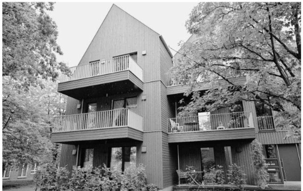
Der Holzbau wirkt auffallend dicht an die Baumkronen herangebaut. Dass der eigentlich vorgeschriebene Abstand zwischen Kronen und Dach beziehungsweise Außenwänden nicht eingehalten werden musste, liegt an zwei unter Flur verlegten Hauptleitungen, die das gesamte Quartier mit Fernwärme versorgen.
